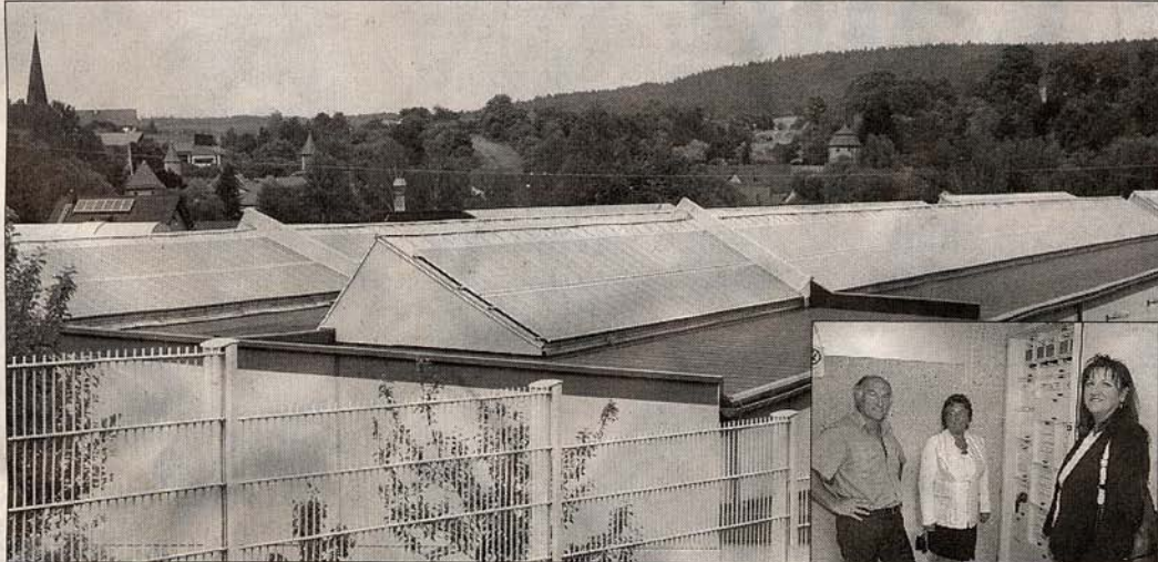
Den Schalter umlegen, und die Sonne kommt vom Dach (großes Bild): Die Geschäftsführer Manfred und Klara Geiss sowie Gerti Ebtsch von der gleichnamigen Photovoltaik-Herstellerfirma in Ebensfeld (kleines Bild, von links) starteten die Anlage.
